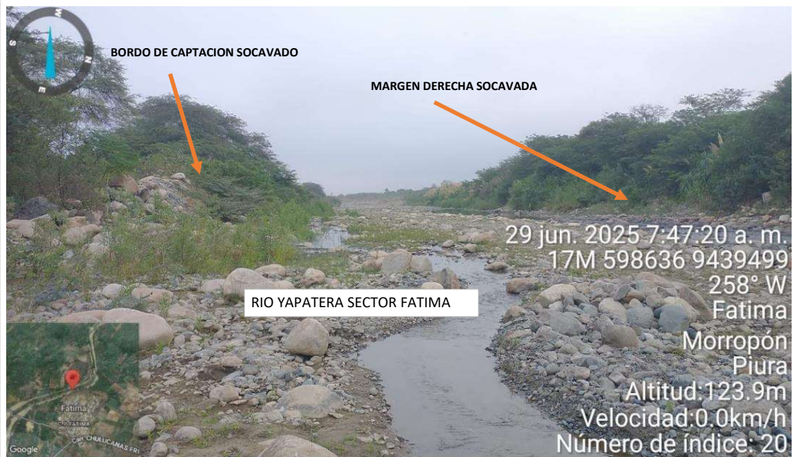
Figura N° 03: EN LAS TEMPORADAS DE MAXIMAS AVENIDAS EL RIO YAPATERA COLMATA LA ENTRADA DEL AGUA EN LA BOCATOMA EL CAÑON, TAMBIEN DETERIORA AMBAS MARGENES DE LA CAJA HIDRAULICA DEL RIO, PONIENDO EN RIESGO ZONAS AGRICOLAS ALEDAÑAS
